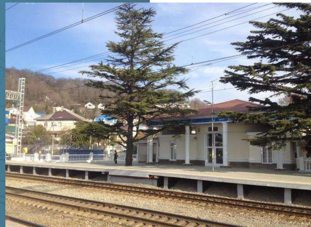
Ж/Д станция «Дагомыс», г. Сочи
